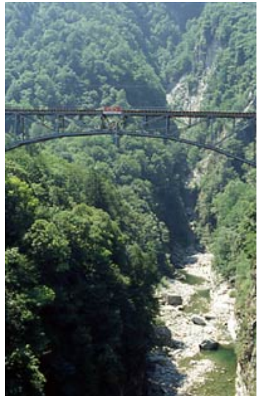
Brücke der Centovallibahn über die Melezza
